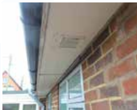
Asbestos soffit.
